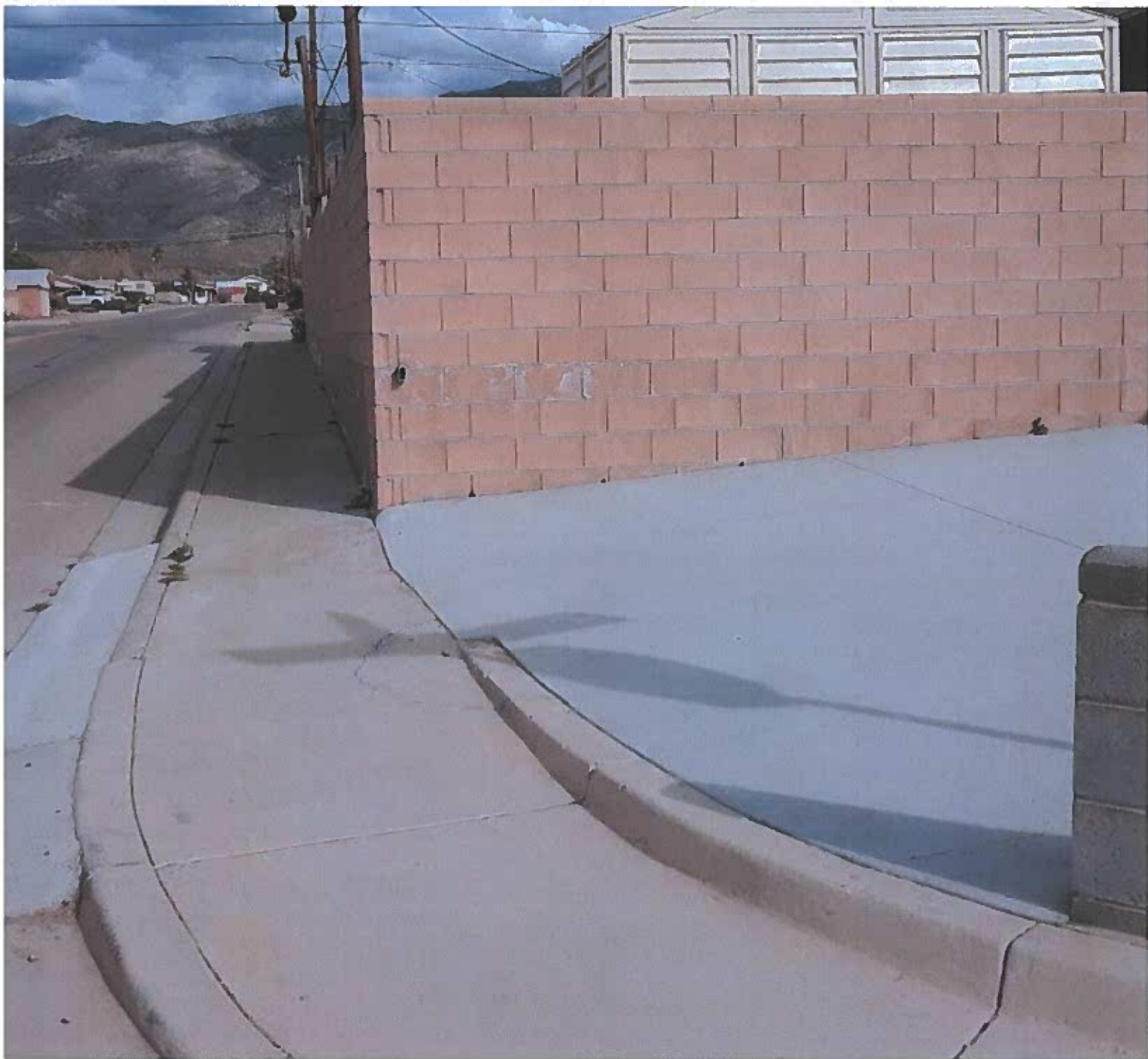
1742 Buena Vista St - Wall sidewalk
